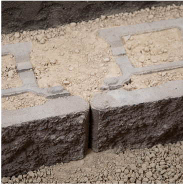
Diagram 5 - Core Fill
