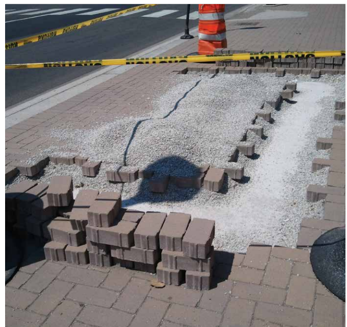
Los adoquines se retiran para permitir una reparación subterránea.
